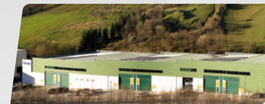
Montagewerk für CNC Drehmaschinen 10.000 m 2 | Mallabia – Spain
