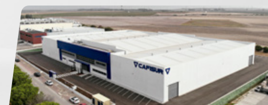
Werk für Blechbearbeitung 15.000 m 2 | Cádiz – Spain
