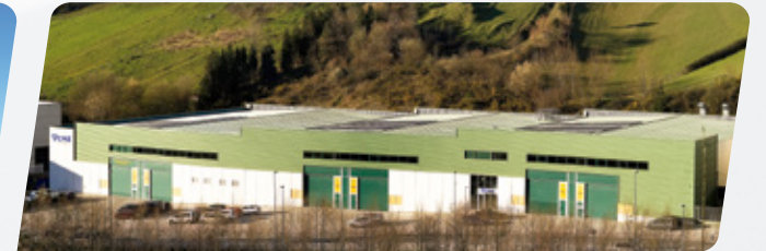
Usine d'assemblage de tours numériques 10 000 m2 | Mallabia – Espagne
