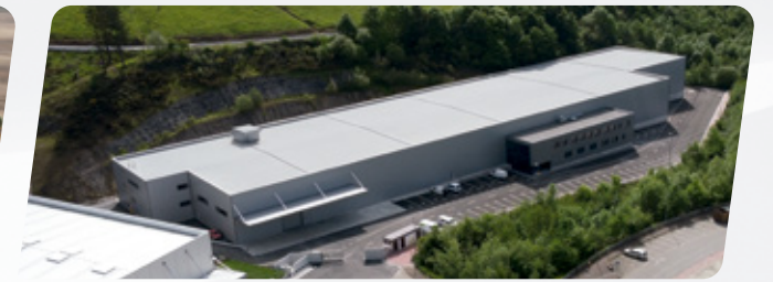
Nouvelle usine de production 10 000 m2 | Mallabia – Espagne
