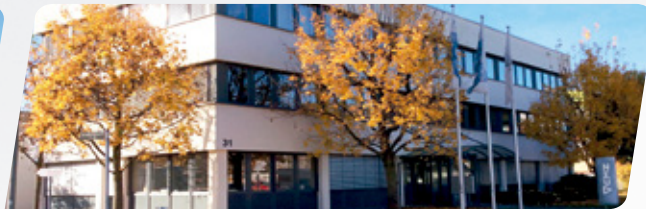
BUREAU COMMERCIAL | SERVICE APRÈS-VENTE Stuttgart – Allemagne
