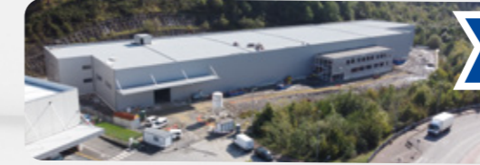
NEOPREC Neue Fertigungsstätte mit FMS, automatischen Lagersystemen und neuesten Technologien.
