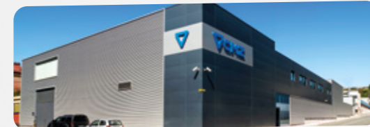
CMZ ASSEMBLY PLANT 1 Montagewerk für CNC Drehmaschinen 5.500 m 2 | Zaldibar – Spain
