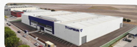
CAFISUR Werk für Blechbearbeitung 15.000 m 2 | Cádiz – Spain
