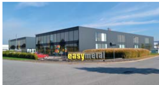
Produktion in der neuen Anlage.
